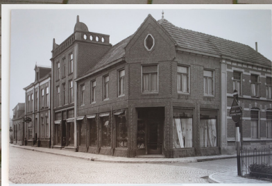
In de hal hangt deze foto van het gebouw dat hier vroeger stond.
